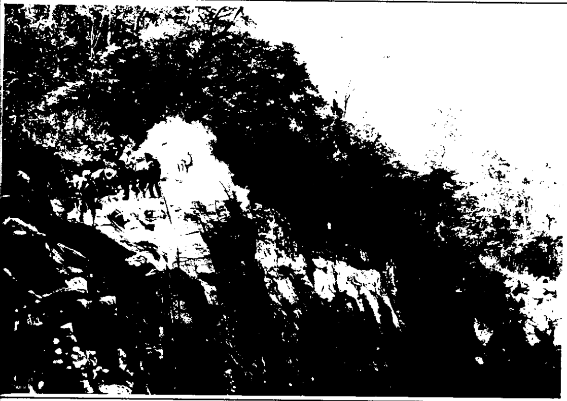
Fot. 09. Execução de furos para a colocação de explosivos no processo de desmonte de rochas em pedreiras (Unai-MG).
